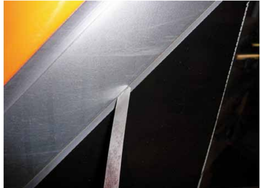
B 14 INNENAUSSTATTUNG_Sikanaht abgelöst
