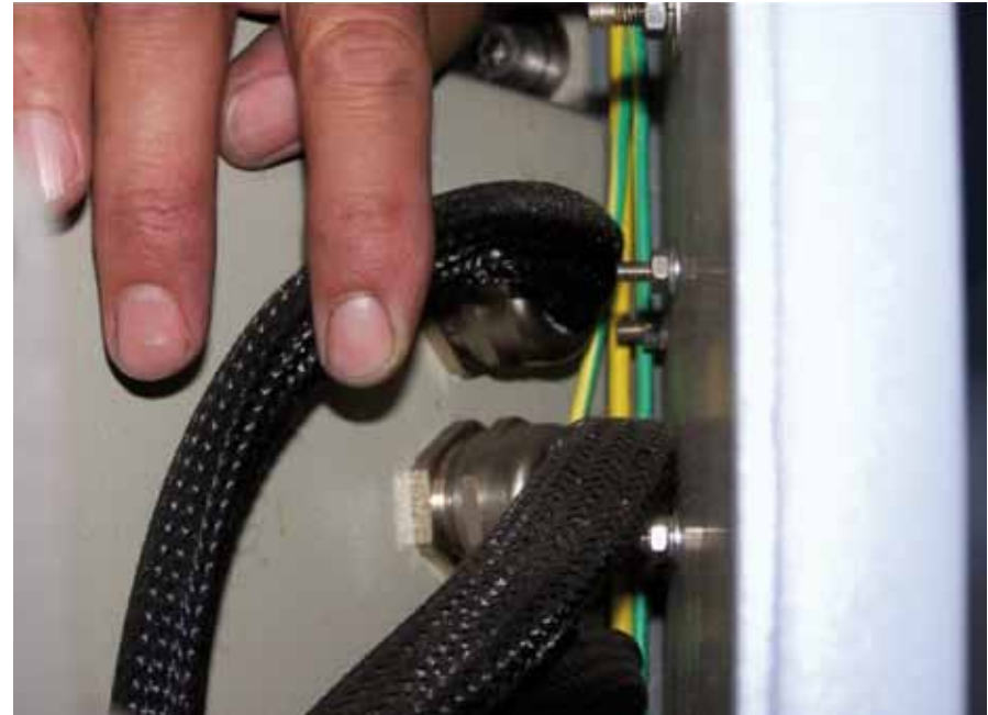
B4 ÜG_KABELVERLEGUNG_E-Leitung liegt an
