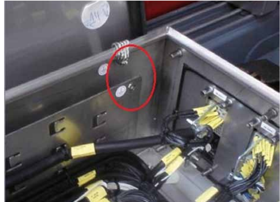
B6 ÜG_ERDUNG _Erdung nicht angeschlossen
